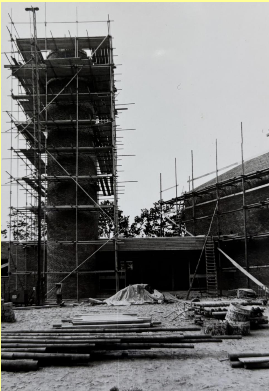
De Moeder Godskerk in aanbouw. Privécollectie W. Admiraal
