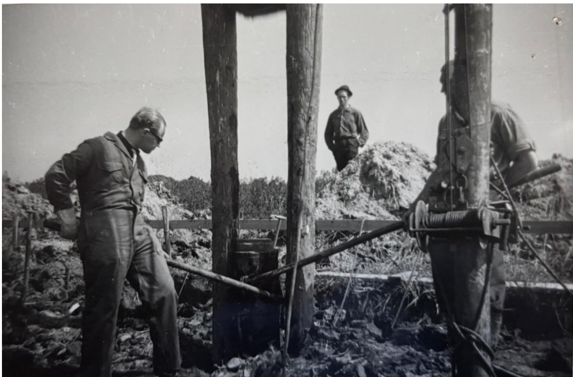
Heiwerkzaamheden 1966. Privécollectie W. Admiraal
