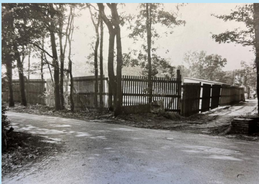
Omheinde bouwplaats voorafgaand aan de bouw van de Moeder Godskerk. Restanten van hekpijlers van 'de Rimboe'. Privécollectie W. Admiraal
